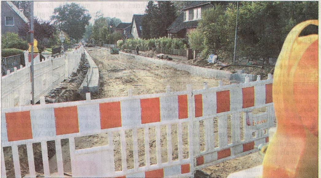
Derzeit ist die Fahrbahn eine Sandwüste. Rechts und links werden die Bordsteine verlegt. Fotos: cb
