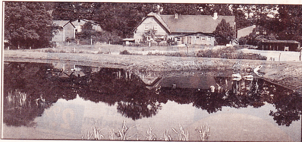
Neue Idylle in den Wiesen unterhalb der Kreisstraße in Schierhorn - das Regenrückhaltebecken der Gemeinde Hanstedt ist fertig. Hier wächst bereits das erste Schilf heran. Im Hintergrund der Hof Marquardt
